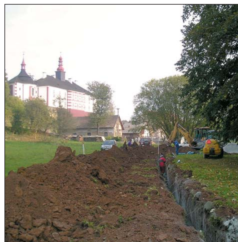
Granty - vodovod Podbřezí Lhota
