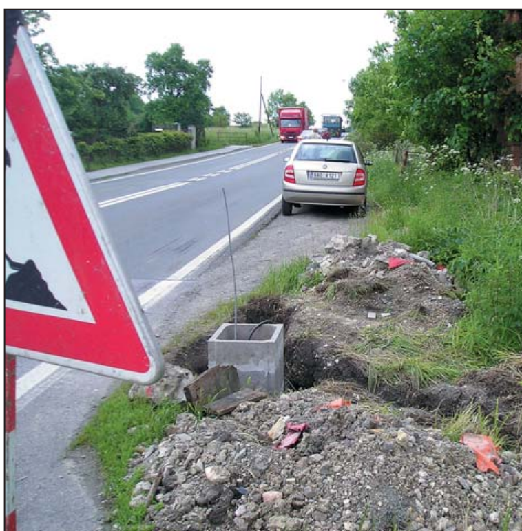
POV - oprava veřejného osvětlení na Cháborách
