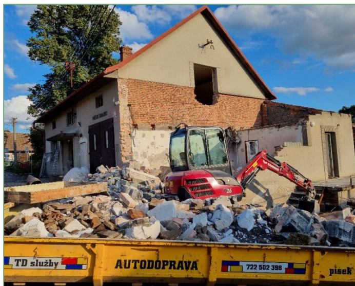
Bourací práce přístavba
