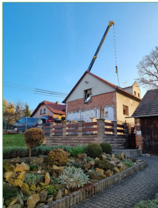
Osazení ocelových nosníků střecha
